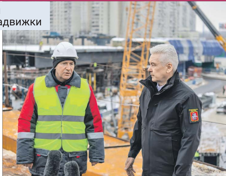
Январь этого года. Мэр осматривает строительство съезда с МКАД на Каширское шоссе
