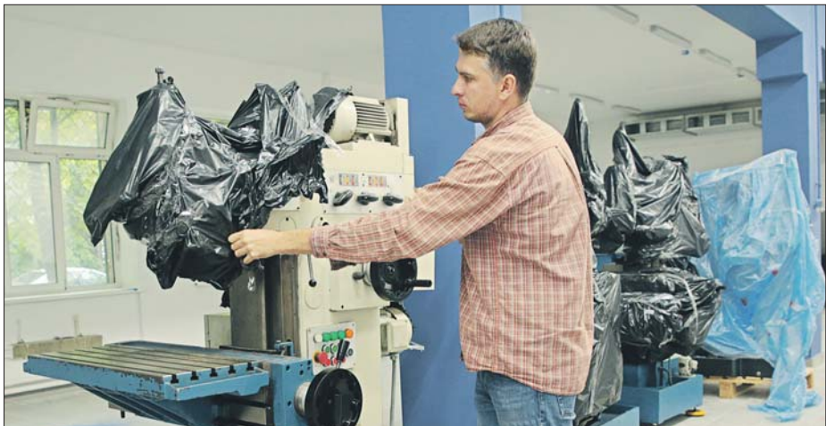
В учебном цехе уже устанавливают станки
