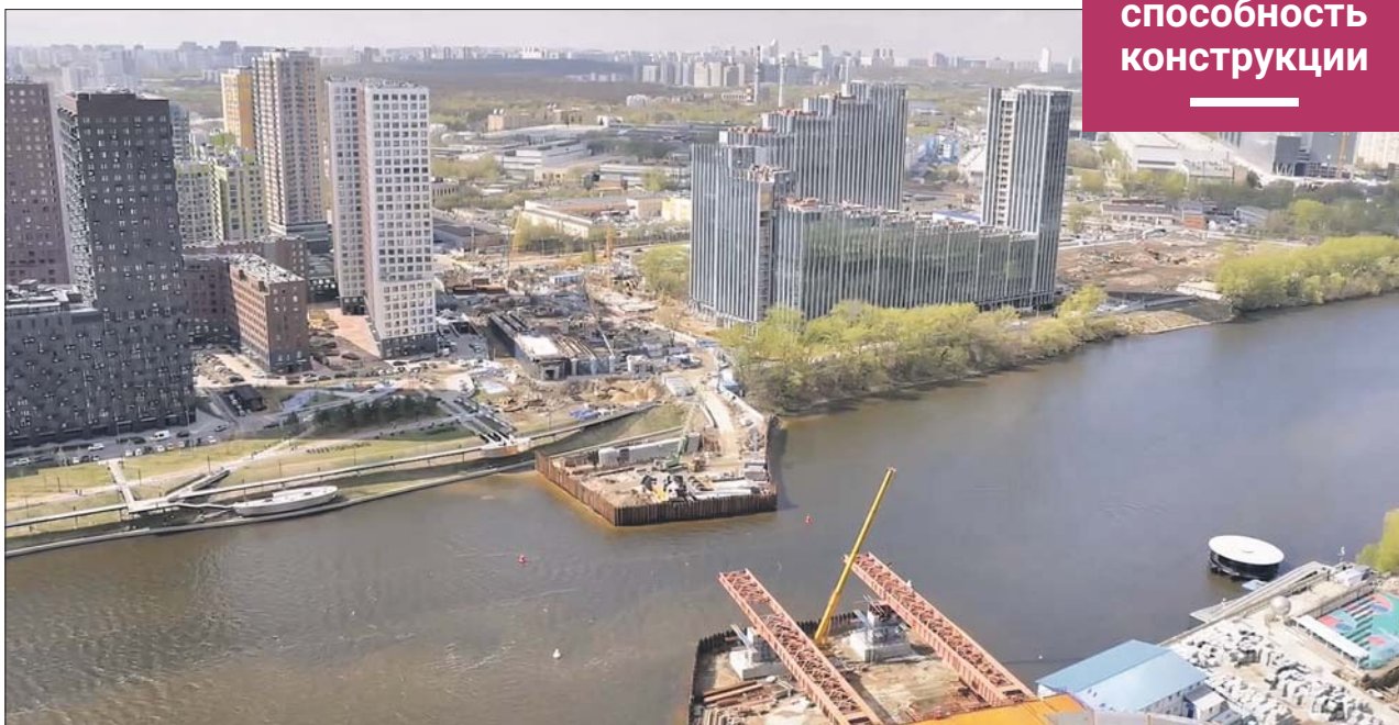
На новом мосту будет по три полосы в каждую сторону
