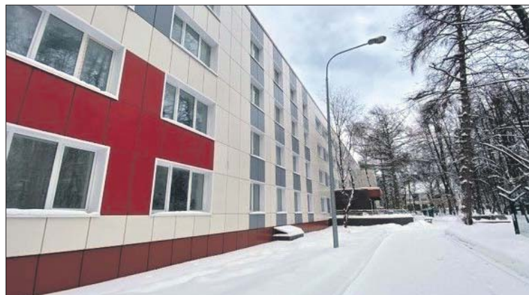
Таким стало здание после ремонта
