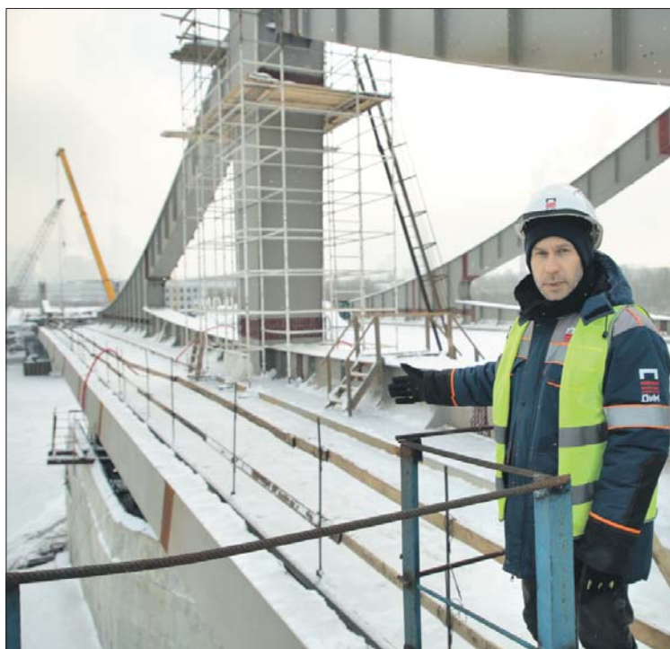
Начальник участка Николай Раевский показывает, что надвигка моста над рекой уже началась
