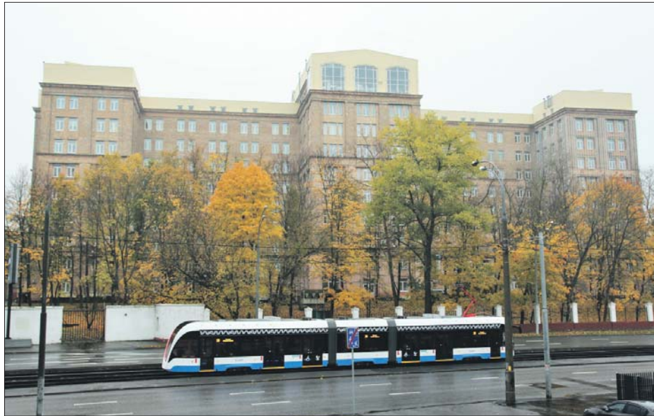
Федеральный медицинский биофизический центр им. А.И.Бурназяна на улице Маршала Новикова
