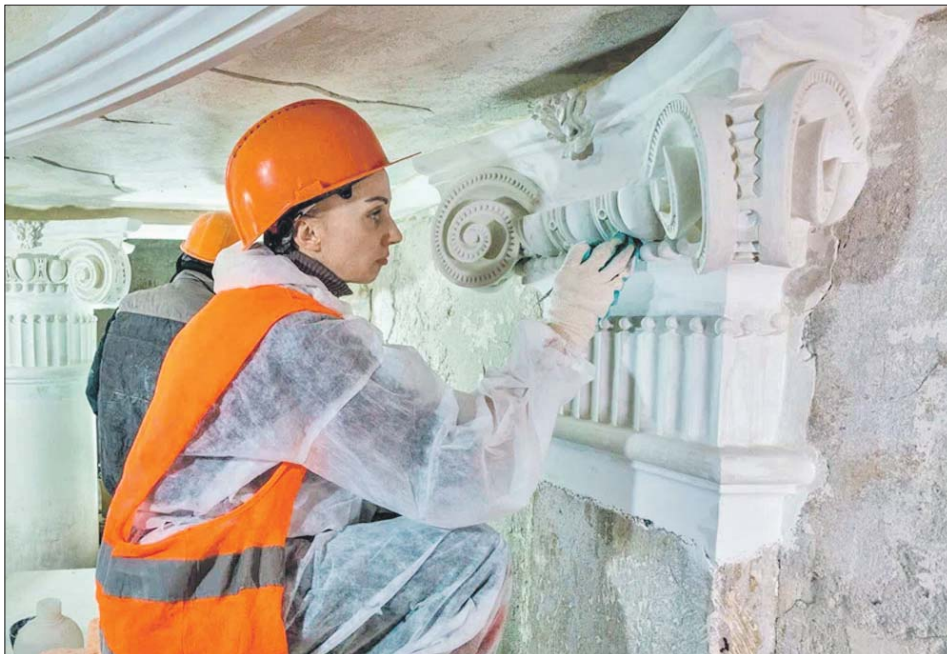
Реставраторы тщательно обрабатывают каждую деталь интерьера
