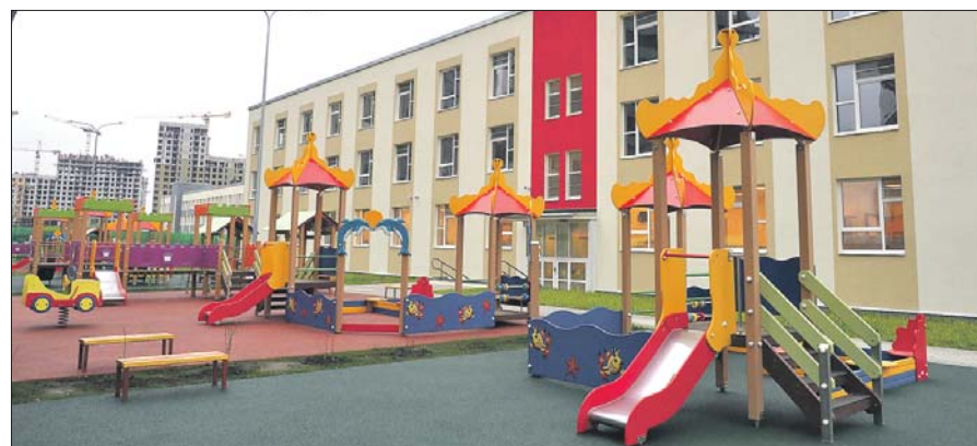
В крупном жилом комплексе по адресу: Волоколамское шоссе, владение 71/9, завершилось возведение корпуса детского сада
