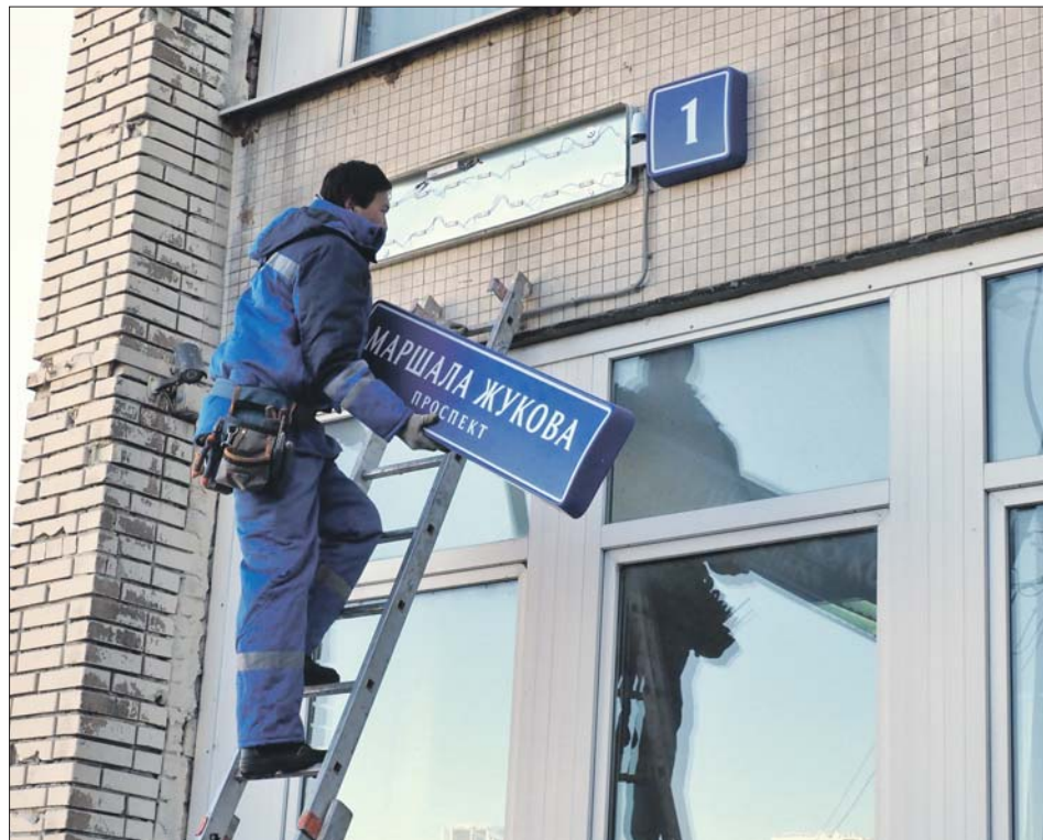
Идёт установка «юбилейного» указателя на проспекте Маршала Жукова
