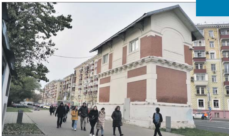
Будка центрального управления стрелками и сигналами
