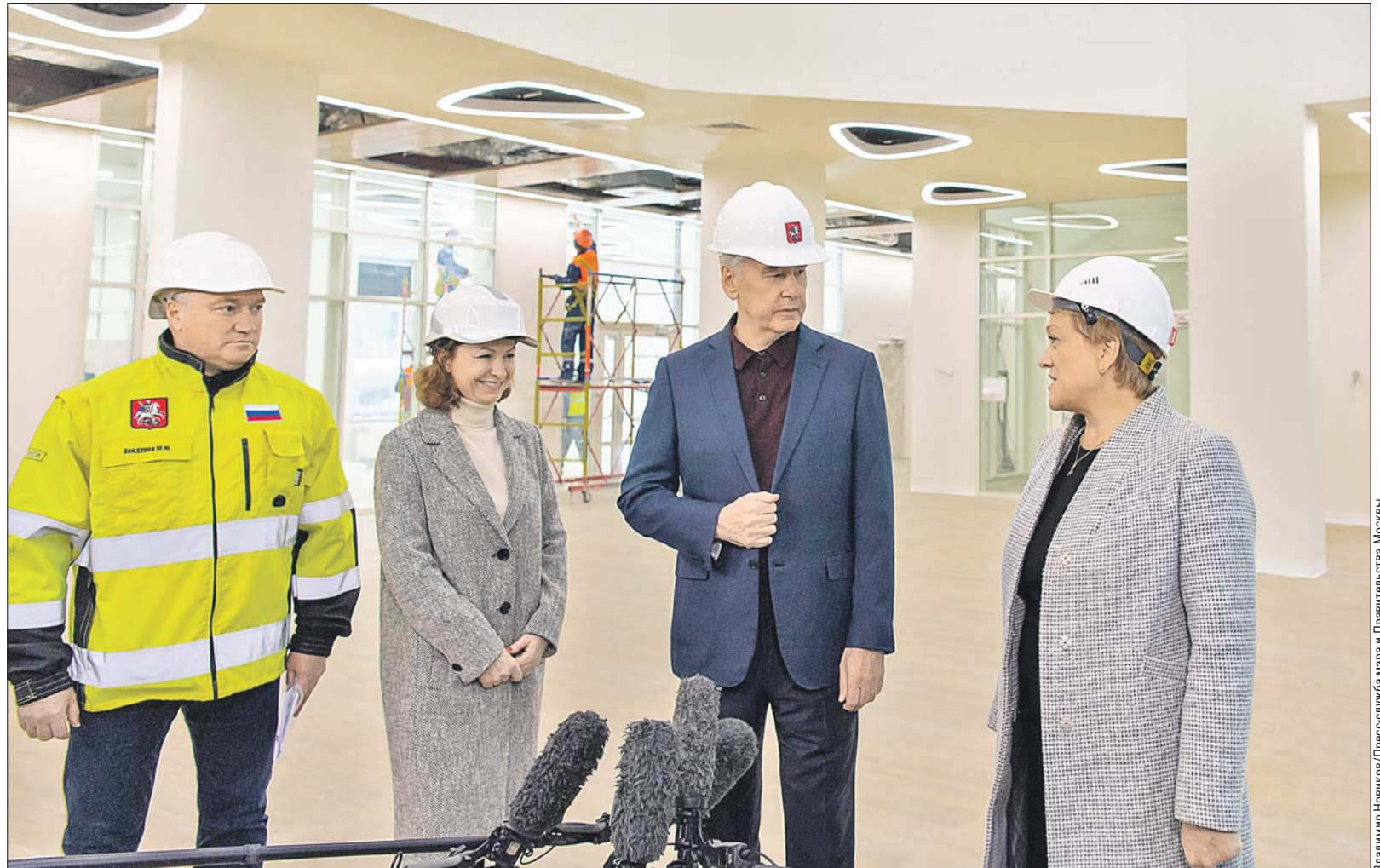
Сергей Собянин в строящемся здании поликлиники в Свиблово
