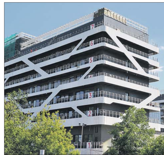
Строительство новых корпусов инфекционной больницы №1 близко к завершению
