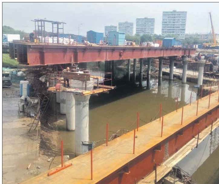
Строители уже возвели новые опоры и приступили к монтажу пролётов
