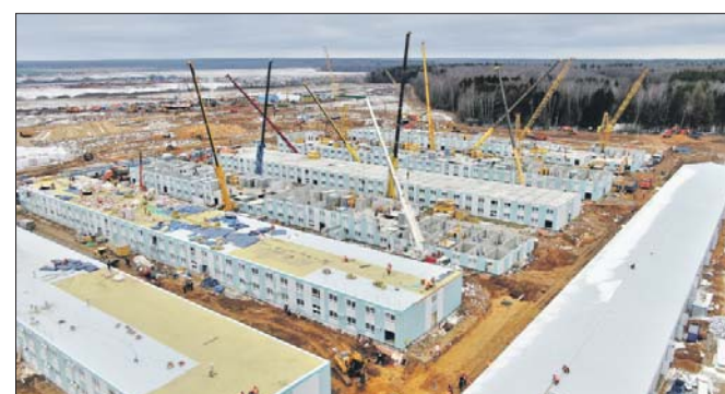
Работа на стройплощадке ведётся круглосуточно
