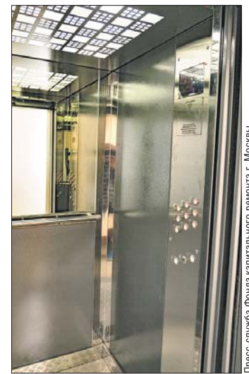
Рабочие заменяют лифтовые кабины и всё оборудование
