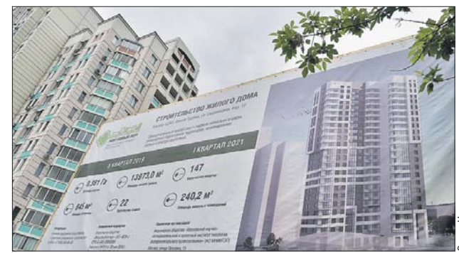
Строительная площадка уже готова к началу работ
