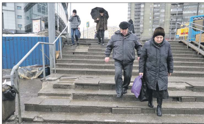
По такой лестнице ходить приходится очень осторожно
