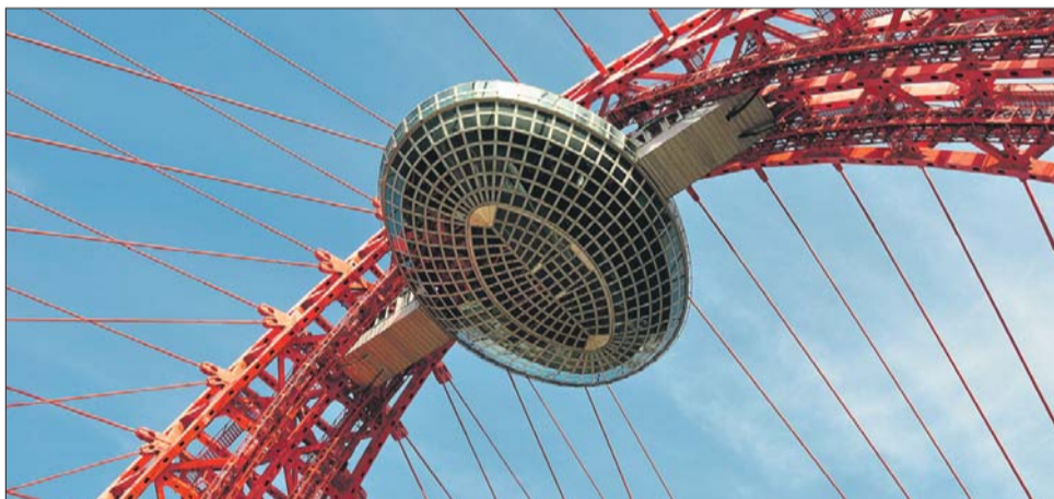
Смотровая площадка в зимнее время стала безопаснее
