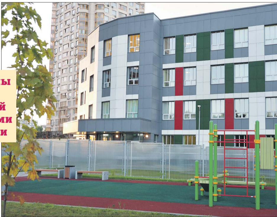
Работы по благоустройству территории завершены
