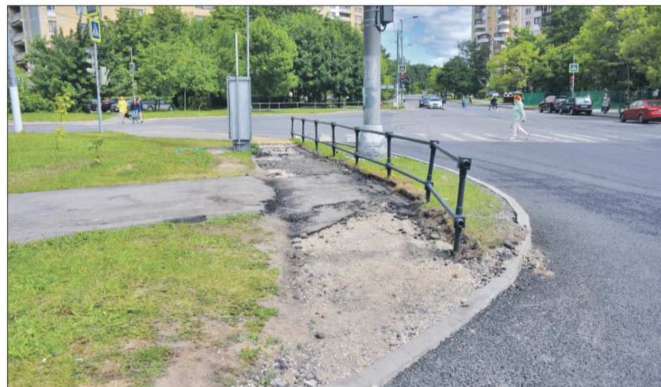
Укладка асфальта должна завершиться к концу июня
