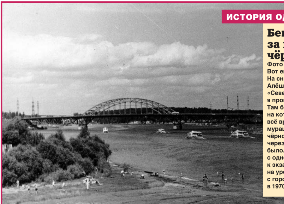
Мост через Химкинское водохранилище
