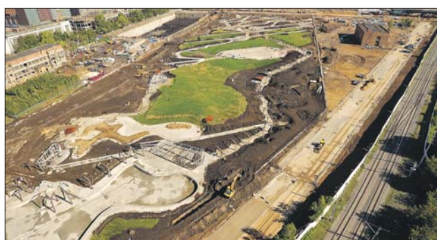
В парке «ЗИЛ» идёт обустройство газона и цветников
