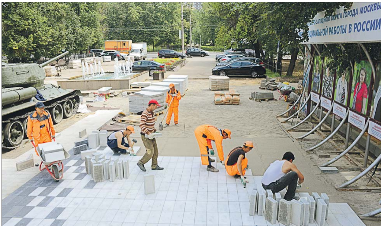
В сквере на улице Свободы, 13, кладут новую плитку
