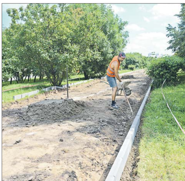
Работы вдоль Пятницкого шоссе
