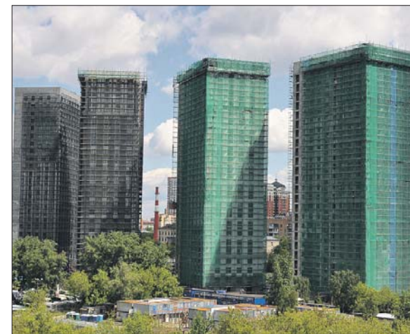
Уже ведутся фасадные и отделочные работы
