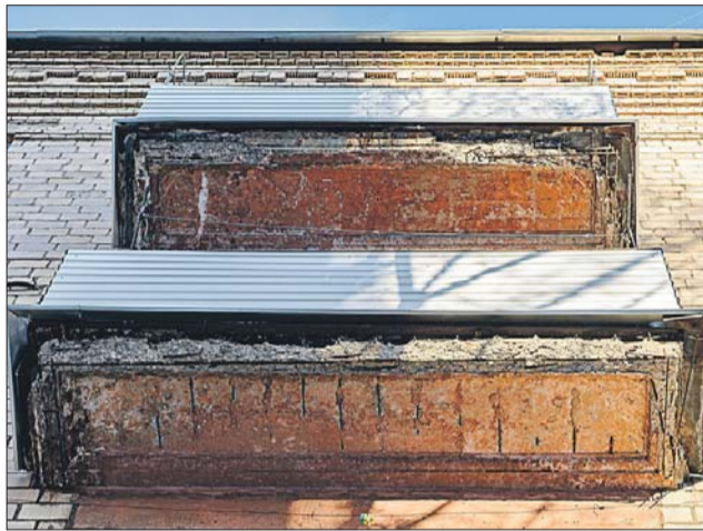
Дом на улице Гамалеи, 7: износ балконов виден невооружённым глазом...
