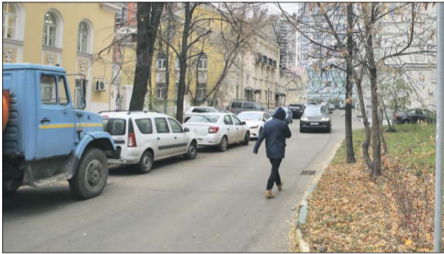
Дополнительный тротуар на проектируемом проезде намечено оборудовать в следующем году
