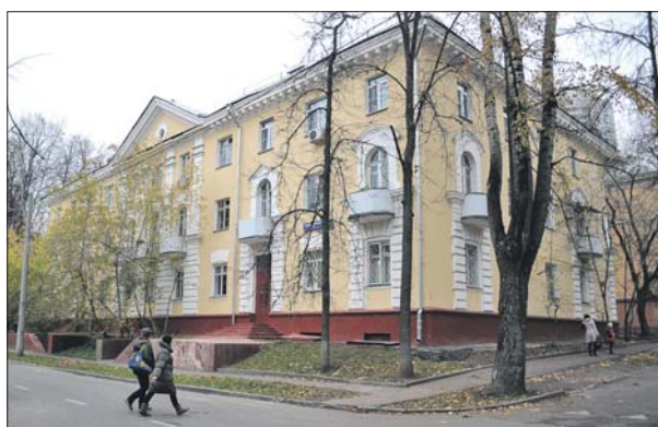
Трёхэтажные сталинки включены в Региональную программу капремонта
