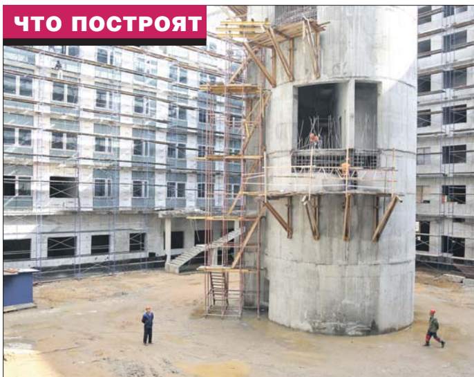
Перинатальный центр строится на месте демонтированного корпуса роддома
