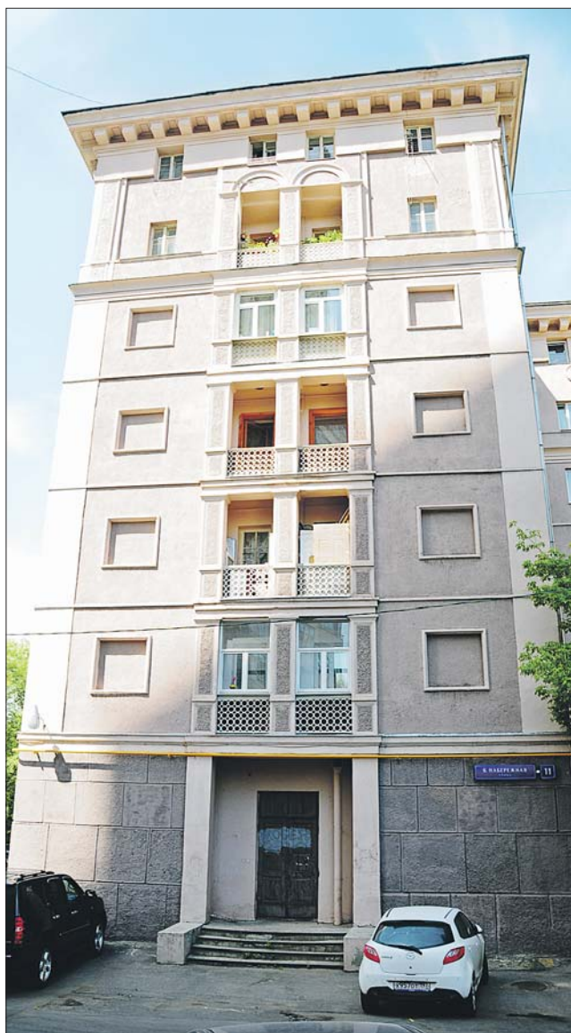
Дом 11 на Большой Набережной построили в 1937-м для руководителей строительства канала имени Москвы
