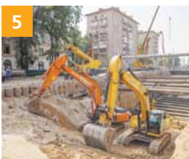
Стройплощадка: Северо-Западная хорда
