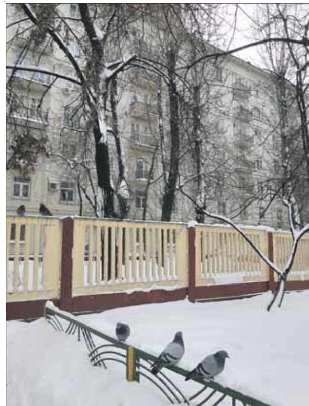
В доме на улице Маршала Бирюзова ремонт проводится так аккуратно, что его даже не все замечают
