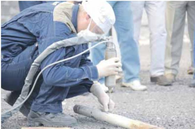
Технология нанесения покрытий позволяет потоком частиц «залатать» любую трубу
