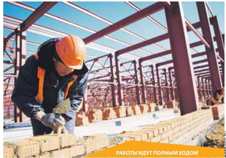
РАБОТЫ ИДУТ ПОЛНЫМ ХОДОМ
